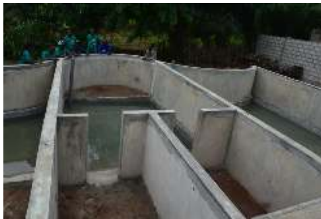
Figure 33 : Construction des bassins d'accueil et des fosses de mise en quarantaine des crocodiles
